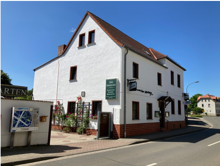
Gasthof und Pension »Zur Erholung«, Blick von Nordosten. Fotograf/Urheber: Josephine Drefßler
