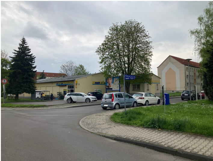
Ehemalige HO-Verkaufsstelle in der Siedlung der AWG »Völkerfreundschaft«, Blick von Nordwesten. Fotograf/Urheber: Isabell Schmock-Wieczorek
