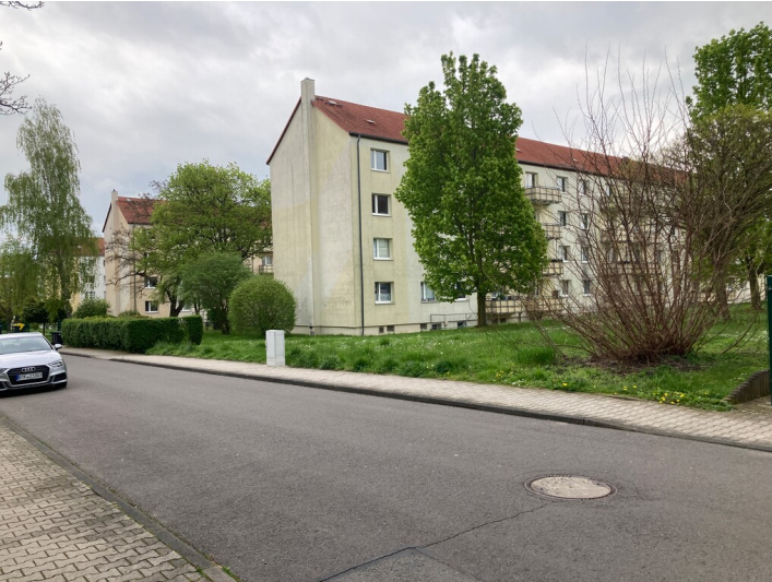
Siedlungshäuser der Wohnungsgenossenschaft Regis-Breitungen, Blick von Westen. Fotograf/Urheber: Isabell Schmock-Wieczorek
