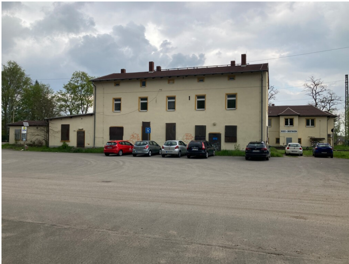
Bahnhof Regis-Breitungen, Blick von Westen. Fotograf/Urheber: Josephine Drefßler
