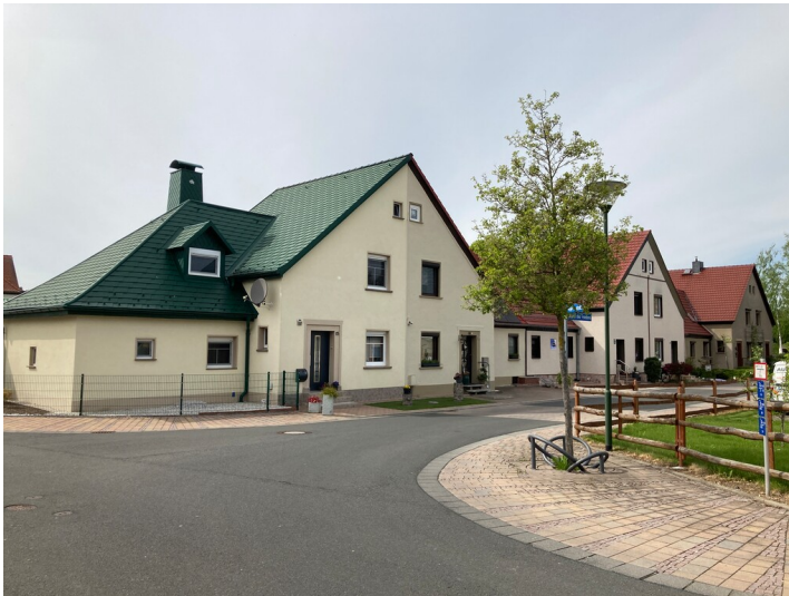
BWG-Doppelwohnhäuser, Blick von Südosten. Fotograf/Urheber: Josephine Drefßler
