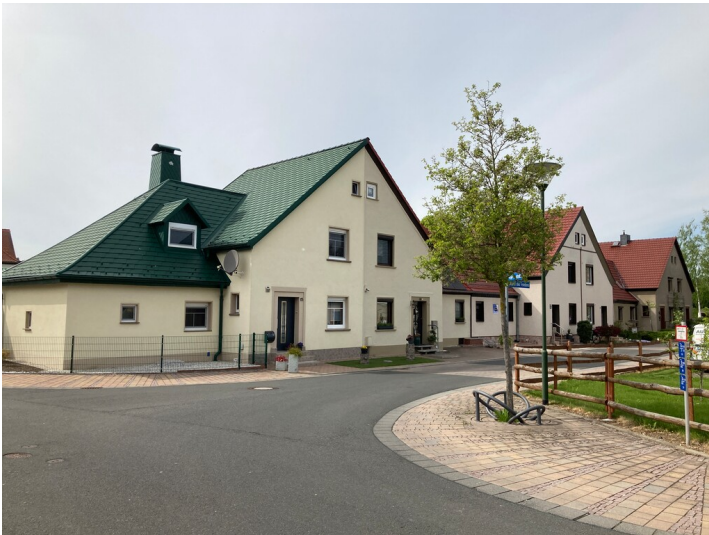
BWG-Doppelwohnhäuser, Blick von Südosten. Fotograf/Urheber: Josephine Drefßler
