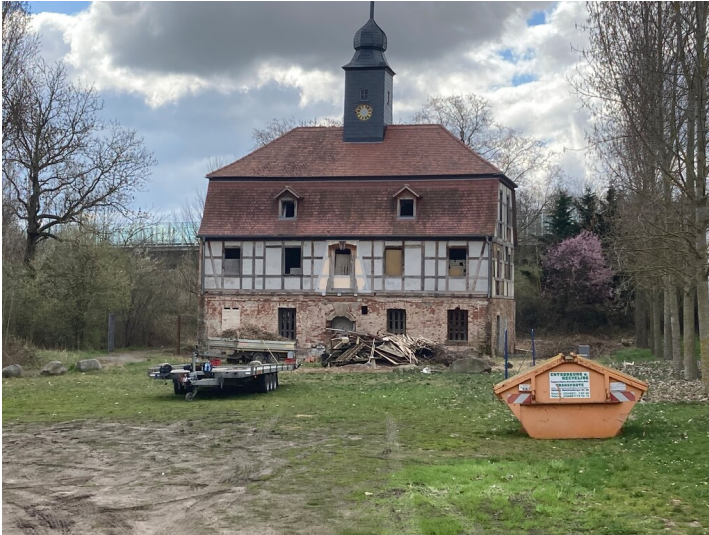
Altes Herrenhaus Gut Gaschwitz, Blick von Norden. Fotograf/Urheber: Christian Schmidt
