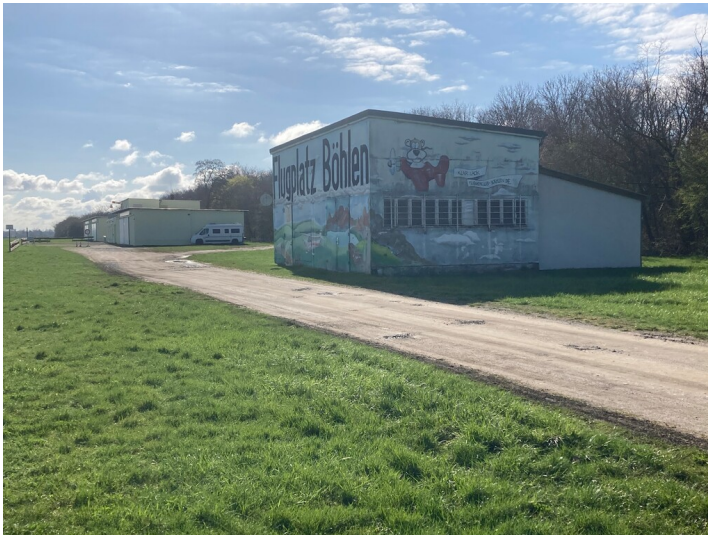
Flugplatz Böhlen, Blick von Nordwesten. Fotograf/Urheber: Christian Schmidt
