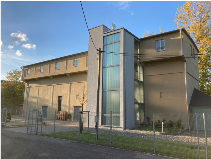
Südwerkbunker des ehemaligen Braunkohlenwerks Dölitz, Blick von Osten. Fotograf/Urheber: Nils Schinker
