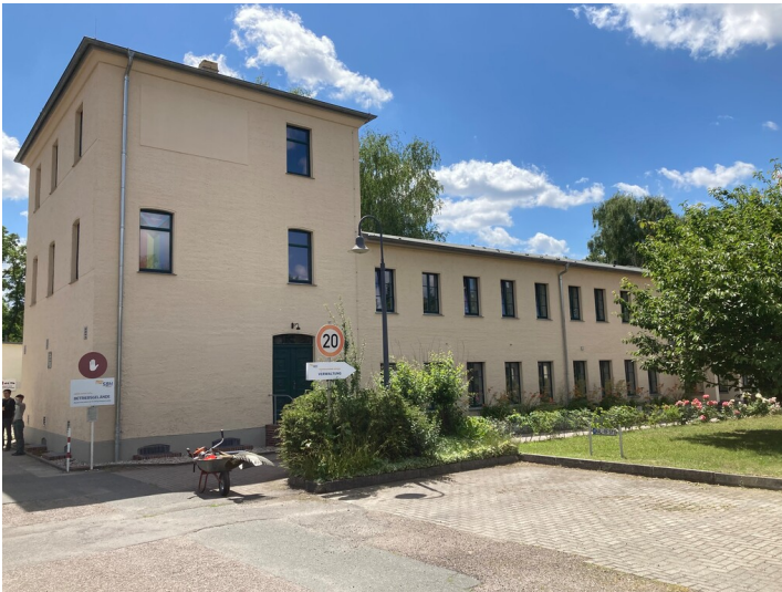
Beamtenhaus des ehemaligen Braunkohlenwerks Dölitz, Blick von Süden. Fotograf/Urheber: Christian Schmidt
