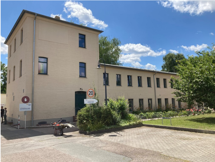
Beamtenhaus des ehemaligen Braunkohlenwerks Dölitze, Blick von Süden. Fotograf/Urheber: Christian Schmidt
