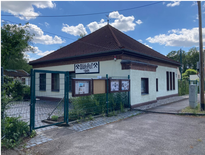
Kontor des ehemaligen Braunkohlenwerks Dölitz, Blick von Nordosten. Fotograf/Urheber: Christian Schmidt
