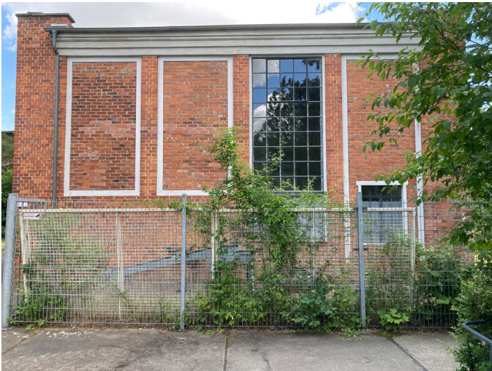
Maschinen- und Kesselhaus des ehemaligen Braunkohlenwerks Dölitz, Blick von Westen. Fotograf/Urheber: Christian Schmidt
