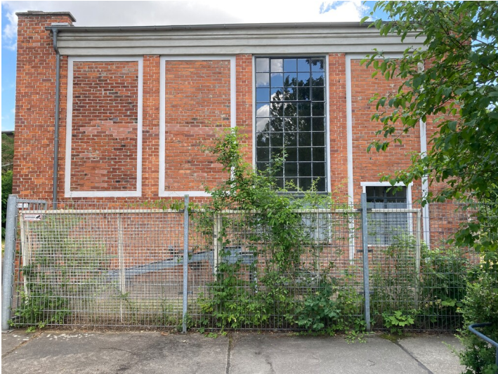
Maschinen- und Kesselhaus des ehemaligen Braunkohlenwerks Dölitz, Blick von Westen. Fotograf/Urheber: Christian Schmidt
