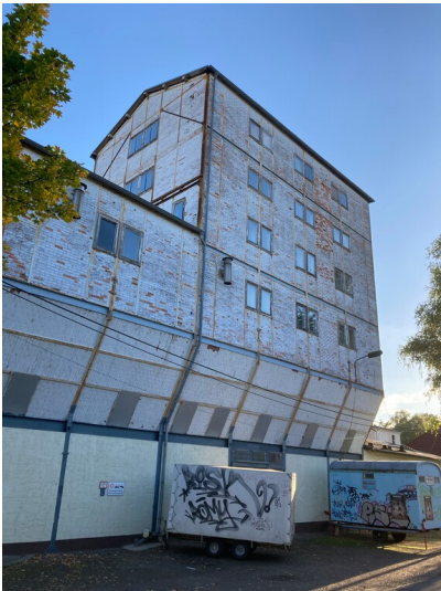
Neue Sortierung des ehemaligen Braunkohlenwerks Dölitz, Blick von Nordosten. Fotograf/Urheber: Nils Schinker
