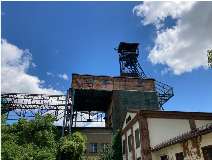
Schachtgebäude mit Förderturm und Alter Sortierung des ehemaligen Braunkohlenwerks Dölitz, Blick von Westen. Fotograf/Urheber: Christian Schmidt
