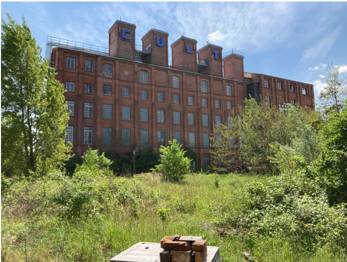
Nass- und Trockendienst mit Pressenhaus der ehemaligen Brikettfabrik Neukirchen, Blick von Nordosten. Fotograf/Urheber: Josephine Dreßler
