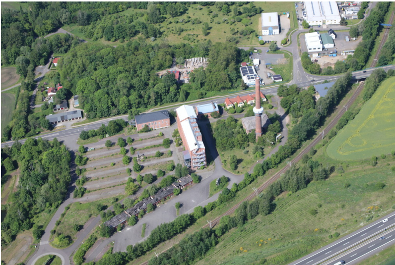
Ehemalige Brikettfabrik Neukirchen, Luftbild von Osten. Fotograf/Urheber: Ronald Heynowski
