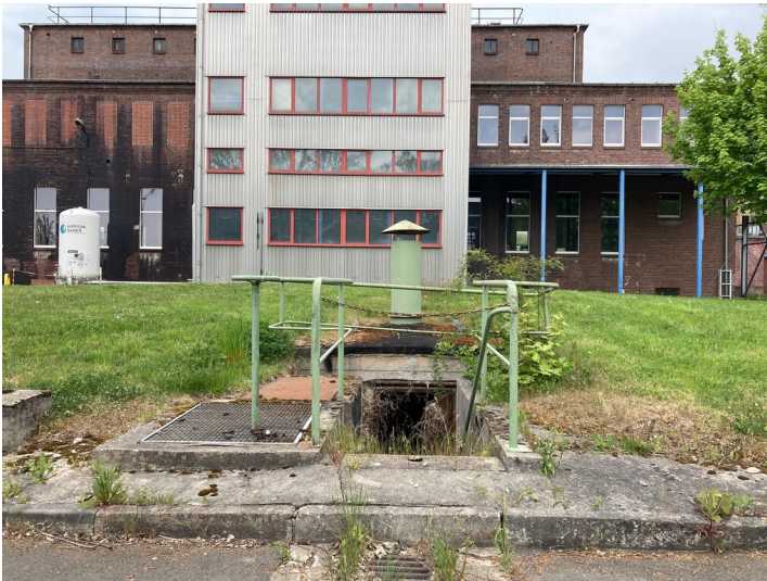
Erdtanklager für gelöste Harze, Raschig Werk, Blick von Süden. Fotograf/Urheber: Christian Schmidt
