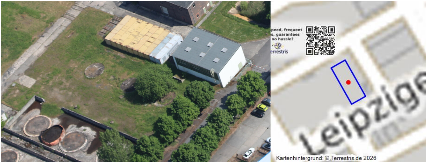
Ehemaliges Formalin-Tanklager, Raschig Werk, Luftbild von Südwesten. Fotograf/Urheber: Ronald Heynowski
