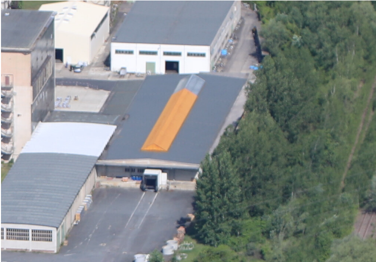
Lager Formmassenbetrieb und technisches Magazin, Raschig Werk, Luftbild von Süden. Fotograf/Urheber: Ronald Heynowski
