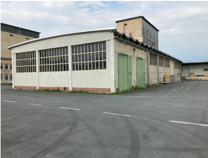
Lager Formmassenbetrieb mit LKW-Garage, Raschig Werk, Blick von Südosten. Fotograf/Urheber: Christian Schmidt
