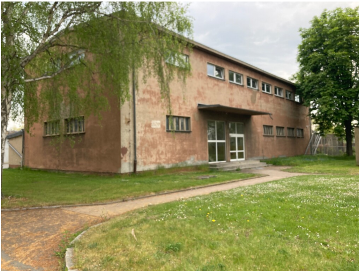
Waschkaue, Raschig Werk, Blick von Nordwesten Fotograf/Urheber: Christian Schmidt
