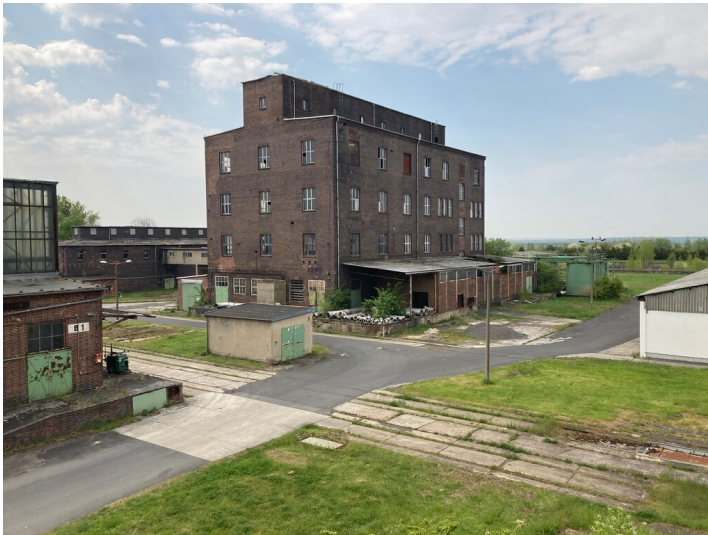
Destillation (ehem.), Raschig Werk, Blick von Nordosten. Fotograf/Urheber: Christian Schmidt
