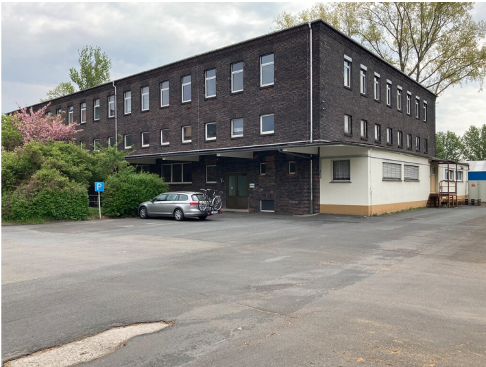
Sozial- und Verwaltungsgebäude mit Kantine, Raschig Werk, Blick von Norden. Fotograf/Urheber: Christian Schmidt
