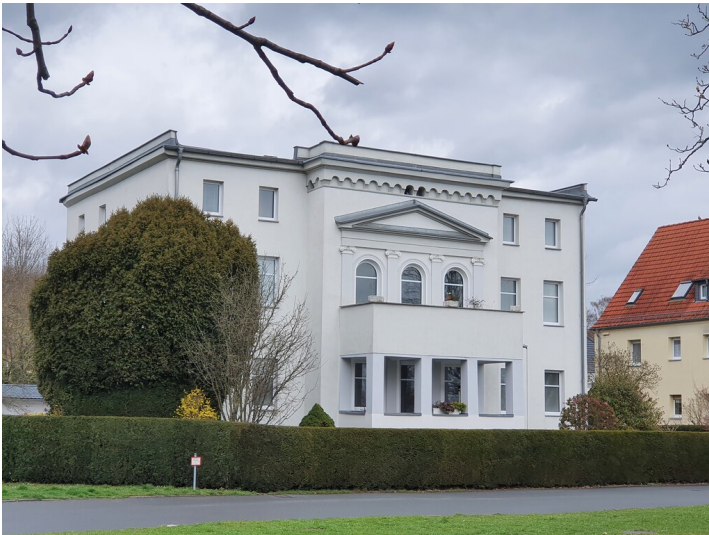
Villa mit Nebengebäude, Blick von Südwest. Fotograf/Urheber: Christian Schmidt
