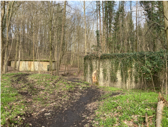
Stahlbetontank der Treibstoff-Destillieranlage Jakob II Fotograf/Urheber: Anja Prust
