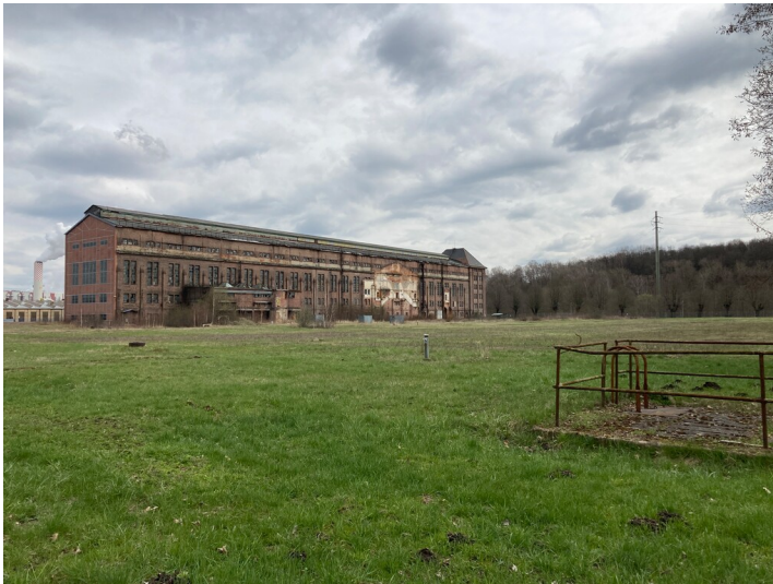
Kraftwerk Hirschfelde, Maschinenhaus Werk II Fotograf/Urheber: Anja Prust
