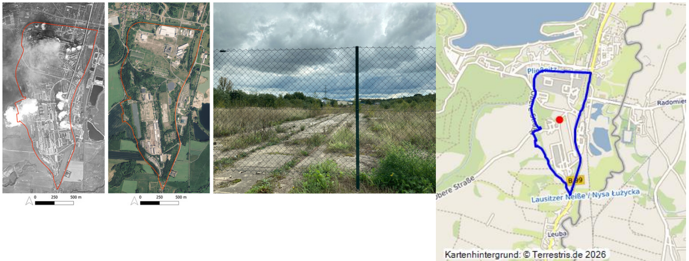
Kraftwerk Hagenwerder 1978 und 2022 (Kartengrundlage: US Geological Survey: Declassified Satellite Imagery 3 [1978]. 2013; GeoSN, dl-de/by-2-0.: DOP Sachsen 2022; Kartierung A. Prust, 2022; Foto: M. Neubacher, LfD Sachsen 2022) Fotograf/Urheber: Anja Prust
