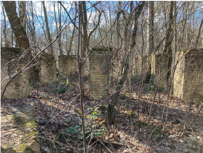
Fundamente der Verladeanlage des Braunkohlenbergwerkes Caroline I Fotograf/Urheber: Anja Prust
