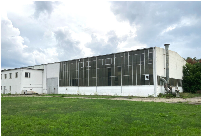
Halle 4 des ehemaligen Haftarbeitslagers der StVE Schwarze Pumpe Fotograf/Urheber: Nora Wiedemann
