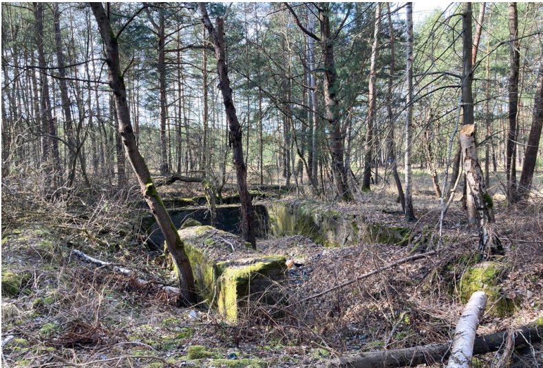
Grube Alice, Fundamentreste der Tagesanlagen Fotograf/Urheber: Anja Prust
