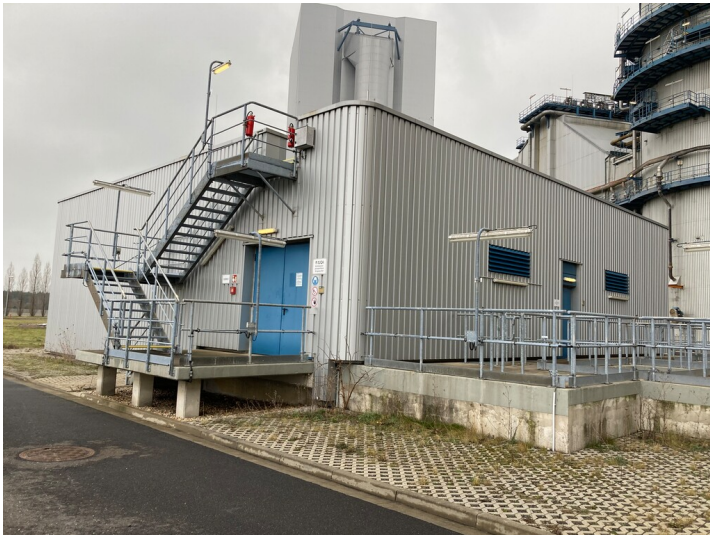
Kraftwerk Boxberg, Kühlwasserpumpenhaus Block R Fotograf/Urheber: Tom Pfefferkorn
