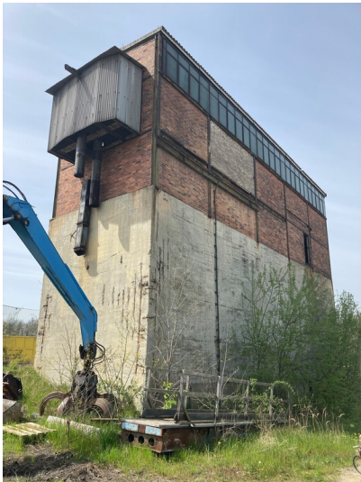
Ehemaliges Braunkohlenwerk Puschwitz, Siebgebäude, von Osten Fotograf/Urheber: Tom Pfefferkorn
