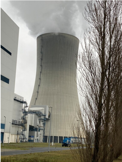
Kraftwerk Boxberg, Kühlturm Block R Fotograf/Urheber: Tom Pfefferkorn
