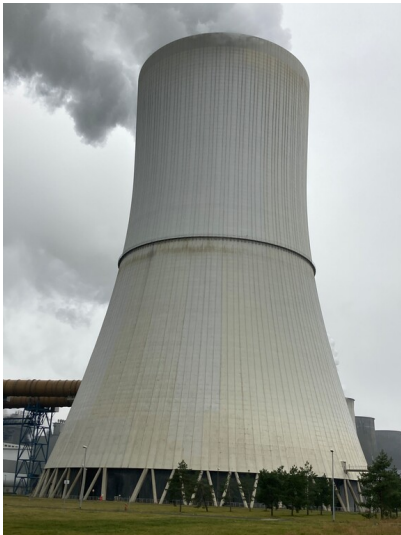
Kraftwerk Boxberg, Kühlturm Block Q Fotograf/Urheber: Tom Pfefferkorn
