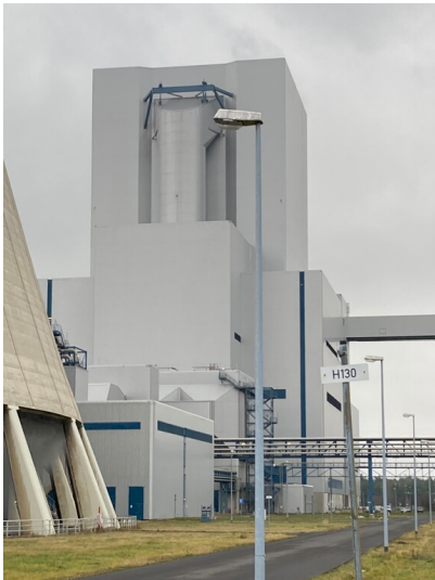
Kraftwerk Boxberg, Block R Fotograf/Urheber: Tom Pfefferkorn
