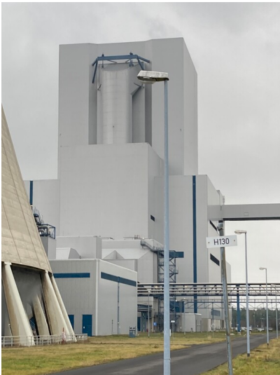
Kraftwerk Boxberg, Block R Fotograf/Urheber: Tom Pfefferkorn
