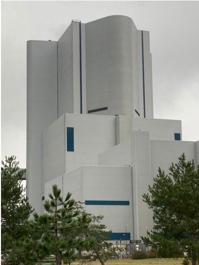
Kraftwerk Boxberg, Block Q Fotograf/Urheber: Tom Pfefferkorn
