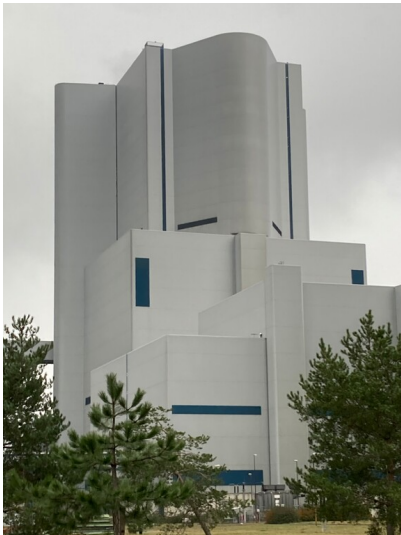
Kraftwerk Boxberg, Block Q Fotograf/Urheber: Tom Pfefferkorn
