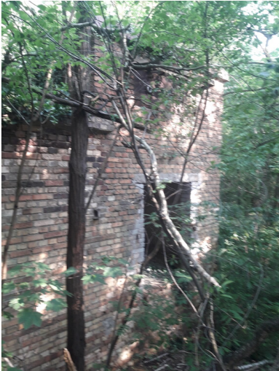
Ehemalige Trafostation der Grubenbahn Fotograf/Urheber: Tom Pfefferkorn
