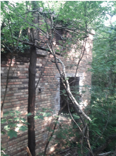
Ehemalige Trafostation der Grubenbahn Fotograf/Urheber: Tom Pfefferkorn
