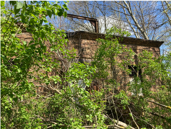
Ehemalige Trafostation der Grubenbahn Fotograf/Urheber: Tom Pfefferkorn
