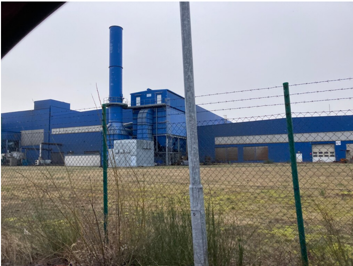
Gießerei SLR, auf dem Gelände der ehem. Siebanlage Sabrodt neu errichteter Produktionskomplex Fotograf/Urheber: Tom Pfefferkorn
