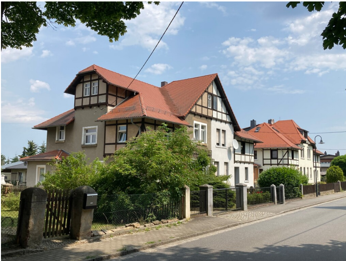
Adolfhütte, Arbeiterwohnhäuser Fotograf/Urheber: Tom Pfefferkorn
