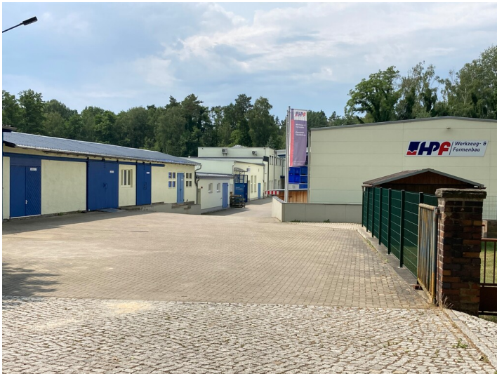
Adolfhütte, Nachfolgebetrieb Fotograf/Urheber: Tom Pfefferkorn
