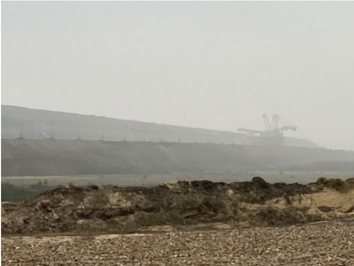
Absetzer Gipsdepot 2001 A2s 1120 Fotograf/Urheber: Tom Pfefferkorn
