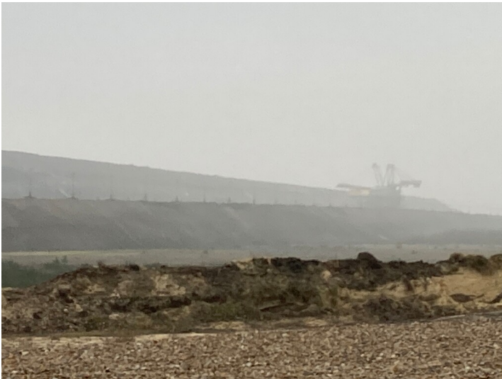
Absetzer Gipsdepot 2001 A2s 1120 Fotograf/Urheber: Tom Pfefferkorn
