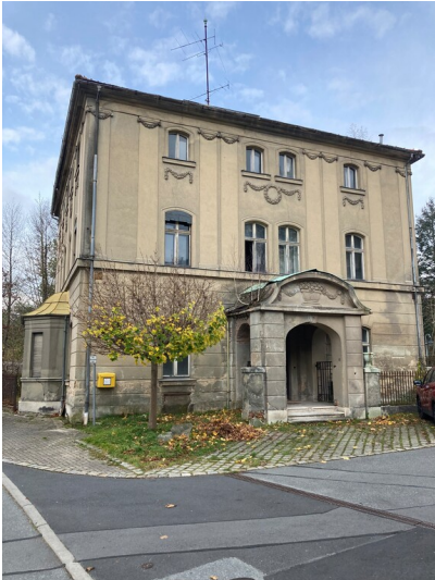
Flachsspinnerei Hirschfelde, Fabrikantenvilla, Ansicht von Osten Fotograf/Urheber: Tom Pfefferkorn
