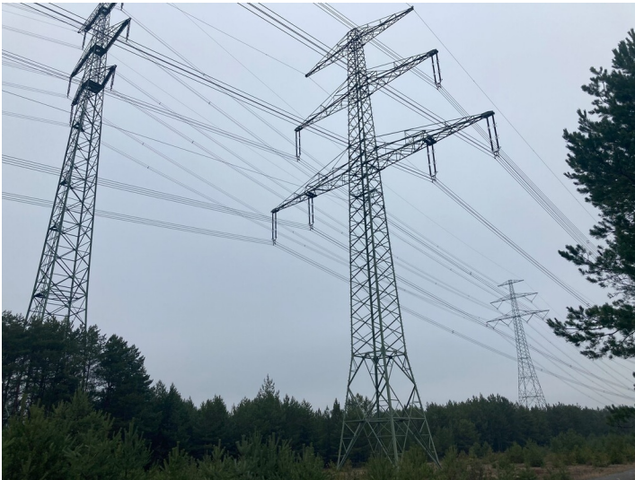
Stark erhöhte Überführung einer Hochspannungsleitung über eine Großgerätetransporttrasse, hier westlich von Bärwalde Fotograf/Urheber: Tom Pfefferkorn
