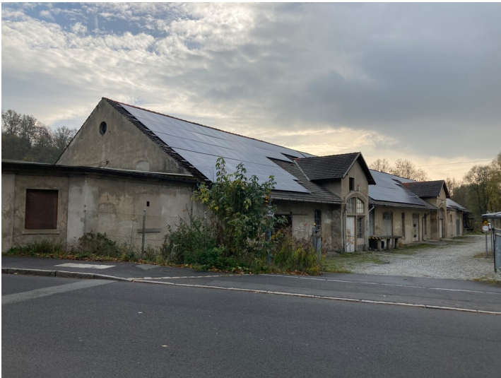
Flachsspinnerei Rosenthal, Magazingebäude von Westen Fotograf/Urheber: Tom Pfefferkorn
