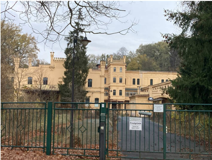
Flachsspinnerei, Hauptfassade, von Osten Fotograf/Urheber: Tom Pfefferkorn
