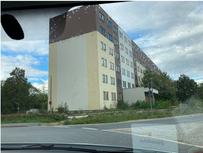
Tagesanlagen Berzdorf, Arbeiterwohnheim, Ansicht von Süden Fotograf/Urheber: Tom Pfefferkorn
