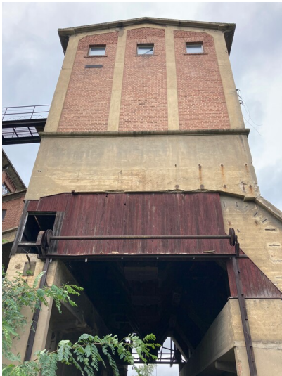
Tagesanlagen Berzdorf, Hochbunker der Siebanlage, Ansicht von Osten Fotograf/Urheber: Tom Pfefferkorn
