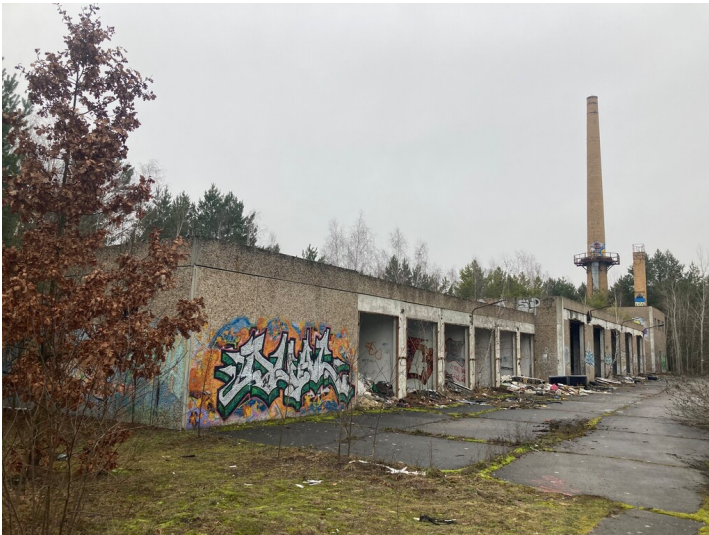
Wohl ehem. Bergbau- oder Armeeobjekt Fotograf/Urheber: Tom Pfefferkorn
