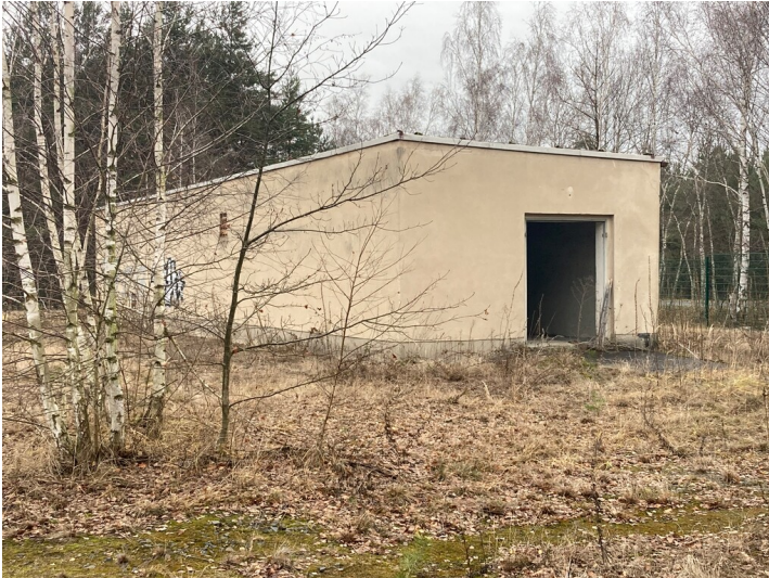
Ehemalige Transformatorenstation an der Abzweigstelle nach Boxberg Fotograf/Urheber: Tom Pfefferkorn
