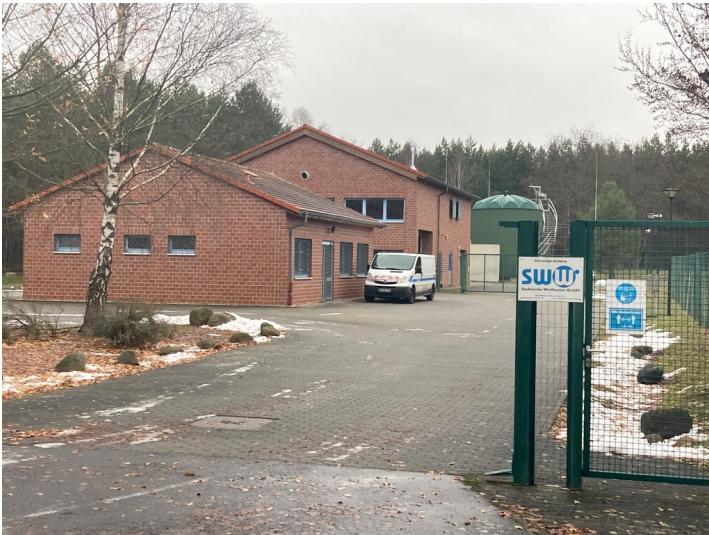
Klärwerk an der B 156 Fotograf/Urheber: Tom Pfefferkorn
