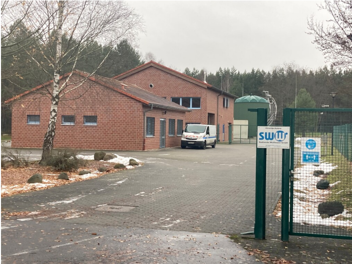
Klärwerk an der B 156 Fotograf/Urheber: Tom Pfefferkorn
