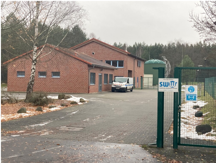
Klärwerk an der B 156 Fotograf/Urheber: Tom Pfefferkorn
