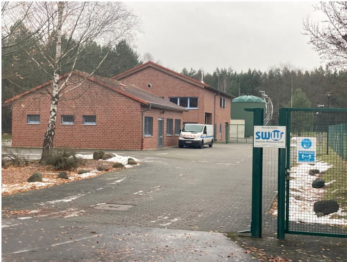
Klärwerk an der B 156 Fotograf/Urheber: Tom Pfefferkorn
